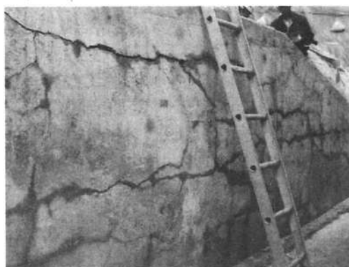
図2 No.O-3のASRによるひび割れ状況 (フーチング部分)
