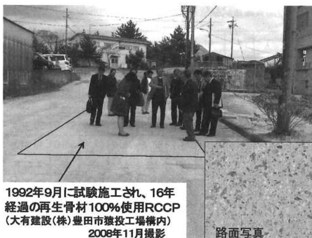
図8 再生骨材使用転圧コンクリート舗装例
