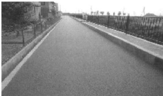
図2 カラー合材施工直後
