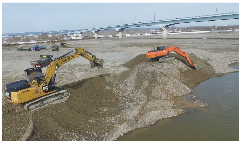
図5.1.7 河川砂利・砂の採取状況
